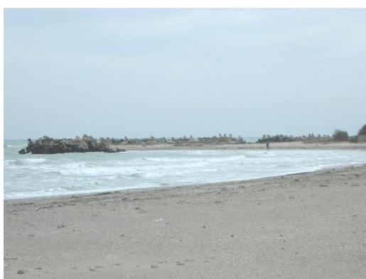
Fig. 4. Dig din anrocamente cu stabilopozi în Venus
