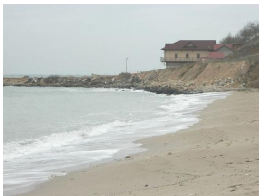
Fig. 7. Eroziunea plajei și falezii la 2 Mai
