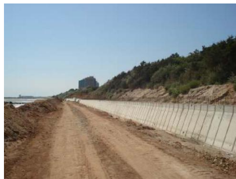
Fig. 1. Lucrări pentru consolidarea falezelor Olimp
